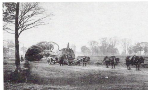
牛を利用しての大木移植風景『樹木根回運搬 & 移植法』第1図
